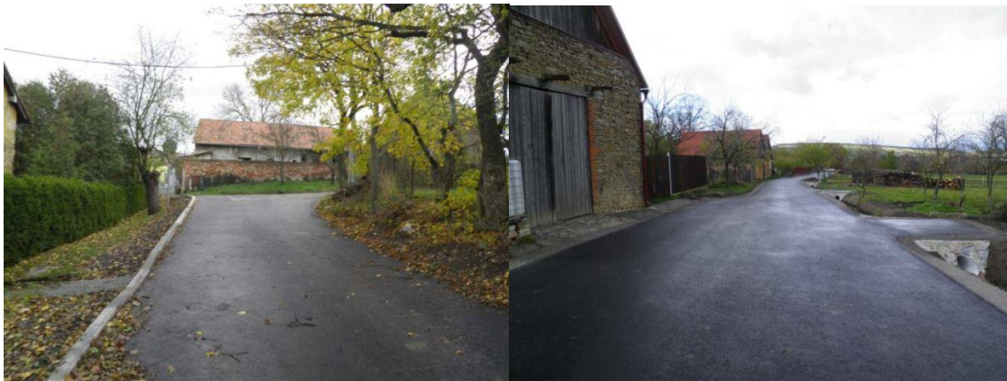
Obr. 8 a 9 Pohled na rekonstruovanou polní cestu
